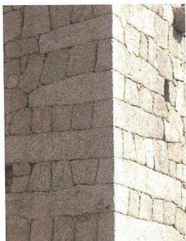
*Guarguale – Ancienne maison forte – Détail d'une chaîne d'angle. Les parements montrent des pierres taillées, assemblées à joint vif, soigneusement ajustées selon leur forme. Les pierres posées à plats dont les bouts sont visibles suggèrent l'épaisseur des murs. La mise en œuvre exprime la solidité de la construction en rapport avec sa fonction.*
